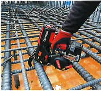
土木工事 橋梁 梁 D51×D25
