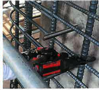
土木工事 橋梁 補強工事 D38×D22
