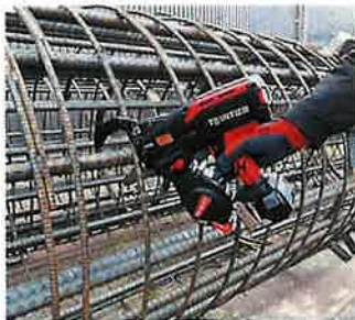
場所打ち杭 鉄筋かご 3層組 D32×D32×D13
